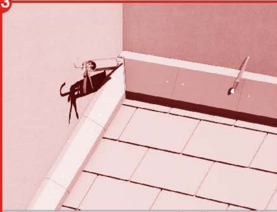
ยาซิลิโคน เอสซีจี ตามแนวรอยต่อ พร้อมเก็บแต่งสิรอยต่อ และหัวตะปูเกลียวให้เรียบร้อย
